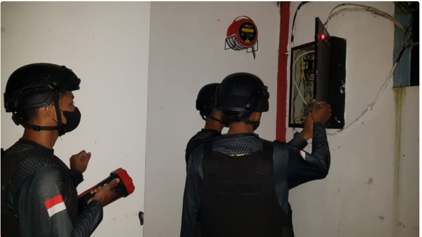
Petugas Lapas Pasir Putih melakukan pengecekan jaringan listrik dan cctv
